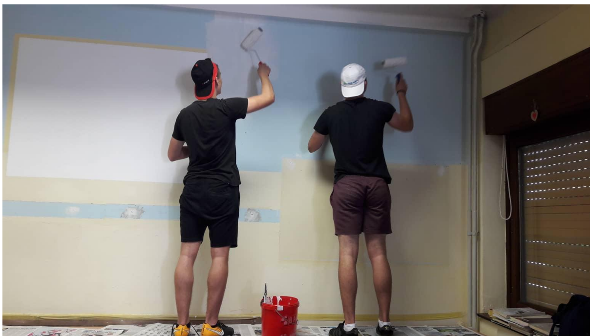
Slika 5 Radovi u tijeku
